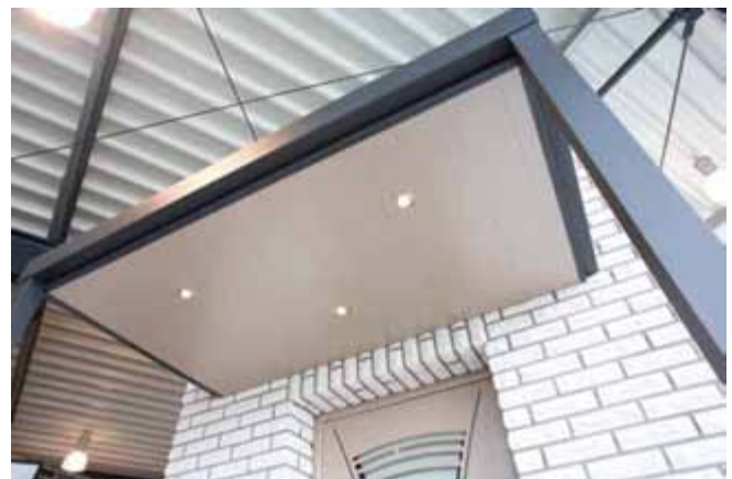
Unteransicht Aluminiumblech genutet mit LED-Strahler
