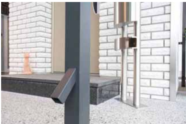
Stützrohr mit Wasserablaufstutzen
