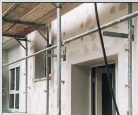
Träger auf festem Grundmauerwerk montiert. (Abb. mit bereits aufgebrachtener Dämmung.)
